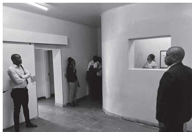
改修工事完了
